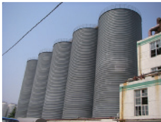
图1 大型容器内壁涂料应用于啤酒发酵罐
